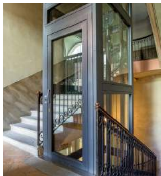
Castelletto metallico installato in interno
