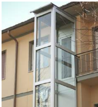
Castelletto metallico installato in esterno
