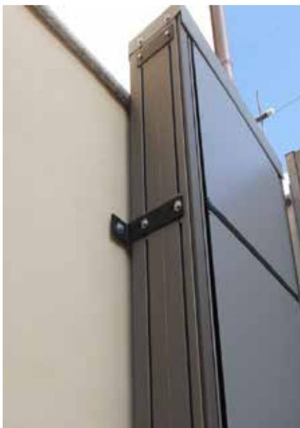
Dettaglio del fissaggio di Opal
